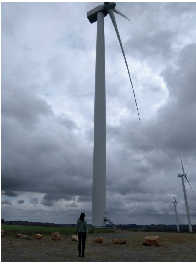
Parc éolien d'Avessac
